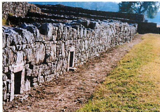
メインストリートに面する排水設備。
